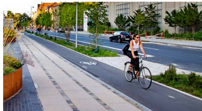
← Skybrudsanlæg på Bülowvej
