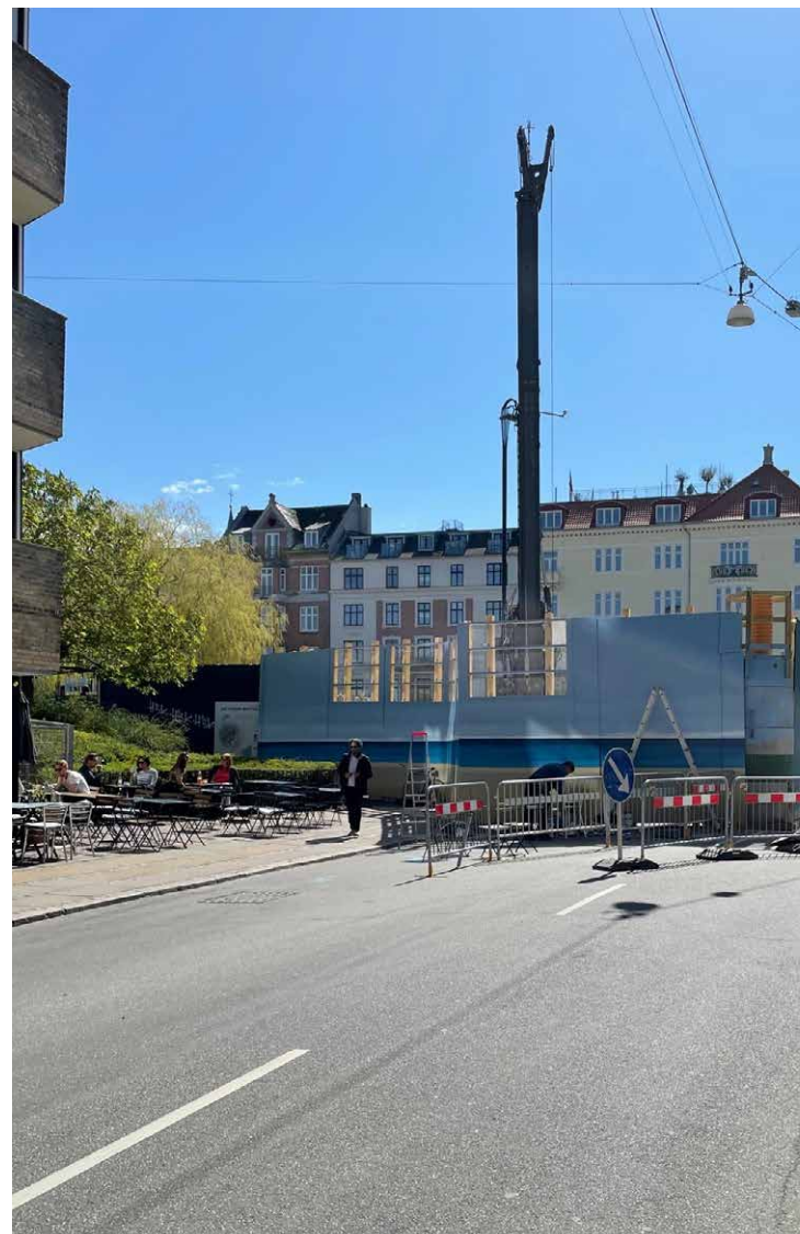
← Etablering af arbejdsskakt på Vodroffsvej.
