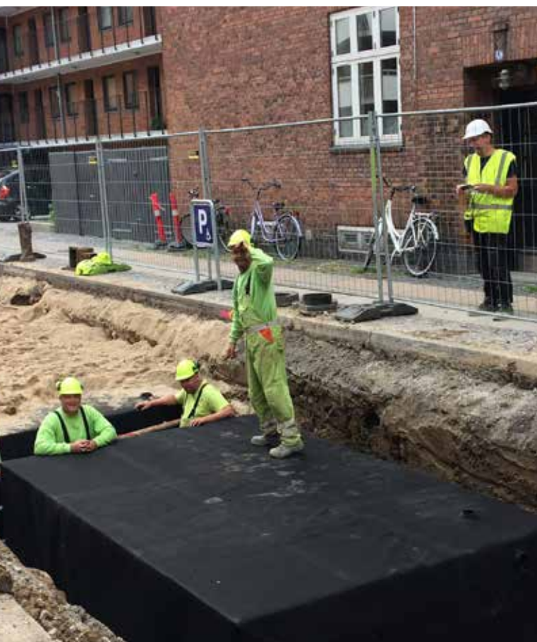
Anlæg af punktvis regnvandshåndtering på Holger Danskes Vej
