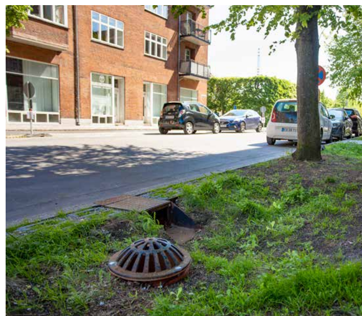
Regnbed med kantstensrist udviklet i samarbejde mellem Frederiksberg Kommune og producent.
