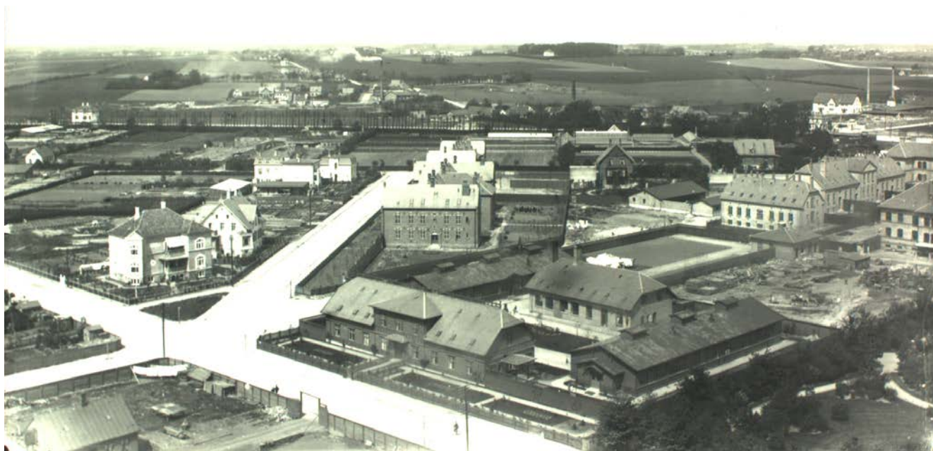
Frederiksberg Hospital. Set fra den 60 meter dampskorsten ved Forbrændingsanstalten på Stæhr Johansens Vej. Bygningerne i forgrunden er epidemi-hospitalet (Nyelandsvej 70), bag disse (til højre) kommunens fattiggård og husvildeafdeling (Nordre Fasanvej 57). De herregårdslignende bygninger ved Stockflethsvej er kommunens alderdomshjem (nr. 4) og børneoptagelseshjem (nr. 6). Længere borte til venstre anes lervarefabrikken Grøndal (Godthåbsvej 181, Vanløse). Den hvide bygning i baggrunden til højre er cementstøberiet Emanuel Jensen & H. Schumacher (Godthåbsvej 140-142), det senere Expanko. Fotograf Barby optog otte billeder fra dampskorstenen - dette er det nordvestlige billede 1903. Foto: Frederiksberg Stadsarkiv.
