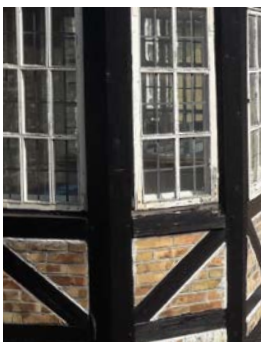
Bindingsværk på skolens hovedbygning, Tårnbergvej 6-8
