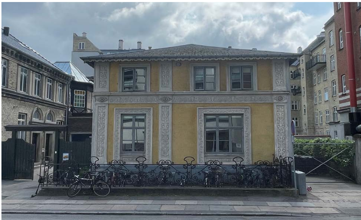
Eksisterende forhold - ornamenter på eksisterende bygning, Tårnborgvej 4
