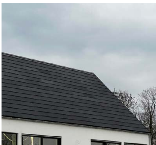
Reference: Skifterlignende mat sort tag af hærde glas med integrerede ikke synlige solceller
