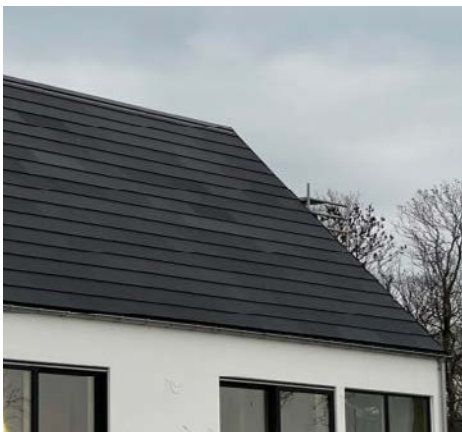
Reference: Skiferlignende mat sort tag af hærdet glas med integrerede ikke synlige solceller
