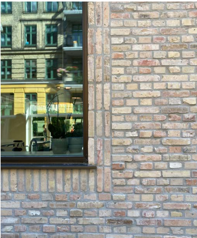
Klub Tempeltræet. Klubbygning til Skolen ved Bülowvej, som omfatter 842 m 2 er opført i 2020. Facaden er udført med genbrugsmursten. Der er udelukkende anvendt FSC-certificeret træ i byggeriet, samt materialer med lav afgasning for at skabe et bedre indeklima. Byggeriet er præcertificeret til en DGNB guldcertificering. Foto: Frederiksberg Kommune.
