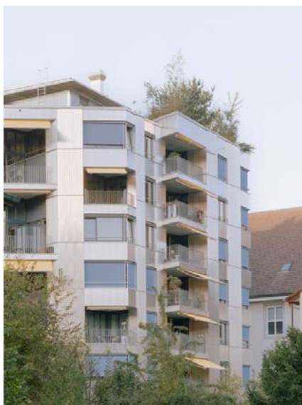
Referencefoto af byggeri med facadeelementer.
