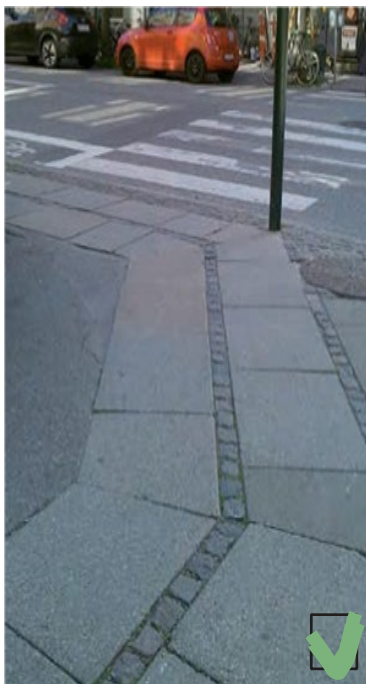
Figur 5: Korrekt udført fortovhjørne
