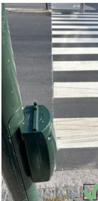
Figur 14: Akustisk signal med retningsgiver
