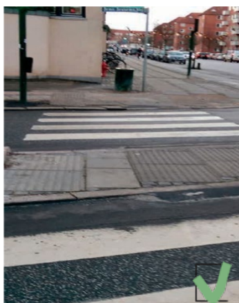
Figur 12: Korrekt udført retnings- og opmærksomhedsfelt i fodgængerhelle.
