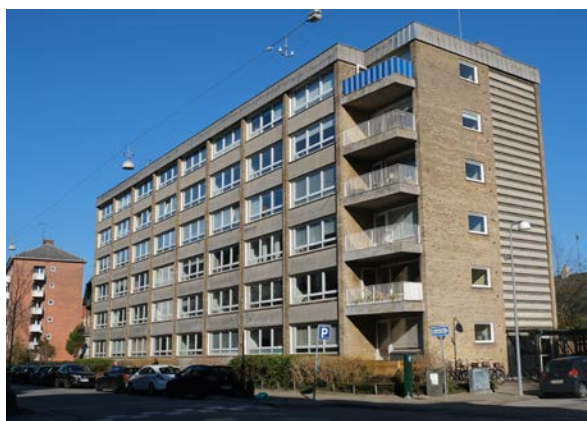
Kong Georgs Vej 52 er opført i 1956 og blev udpeget som bevaringsværdig i Kommuneplan 2021.
