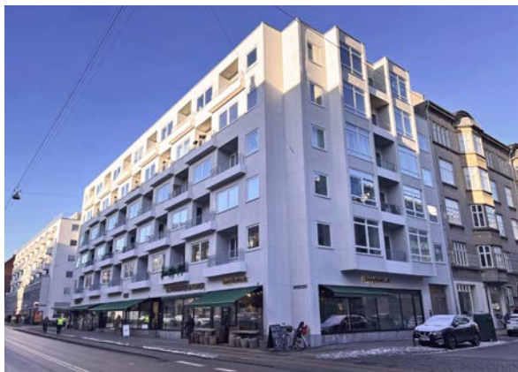
Energirenovering på Gammel Kongevej 70-72
