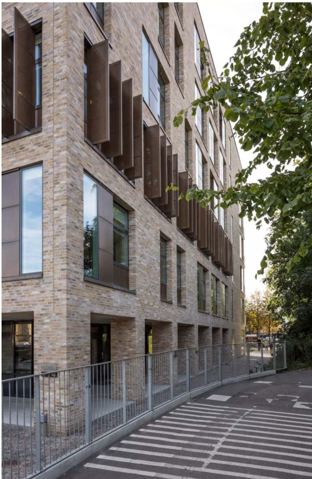
Vinduerne på fødevarebygningen (Wiberg Arkitekter) har en smuk detaljering og placering, der skaber liv i facaden.
