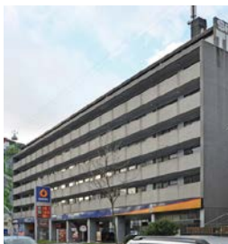
Den gamle facade
