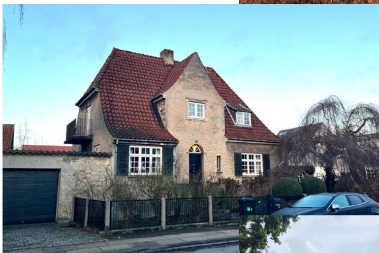
Pelargonievej 14 er omfattet af lokalplan 238 for bygninger med SAVE-værdi 3.
