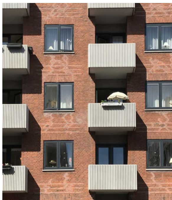
Altanerne på Kingosgade 8/Boyesgade 8-14 er støbt med en profilering og udformning, der ligner de gamle altaner. Projektet blev præmieret i kategorien Den vellykkede ombygning ved Facadepræmiering 2022 (Larsen & Søndergaard Byggerådgivning).
